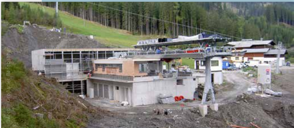
© Architekturbüro Grobbarler Bergbahnen Baustelle Bergstation
